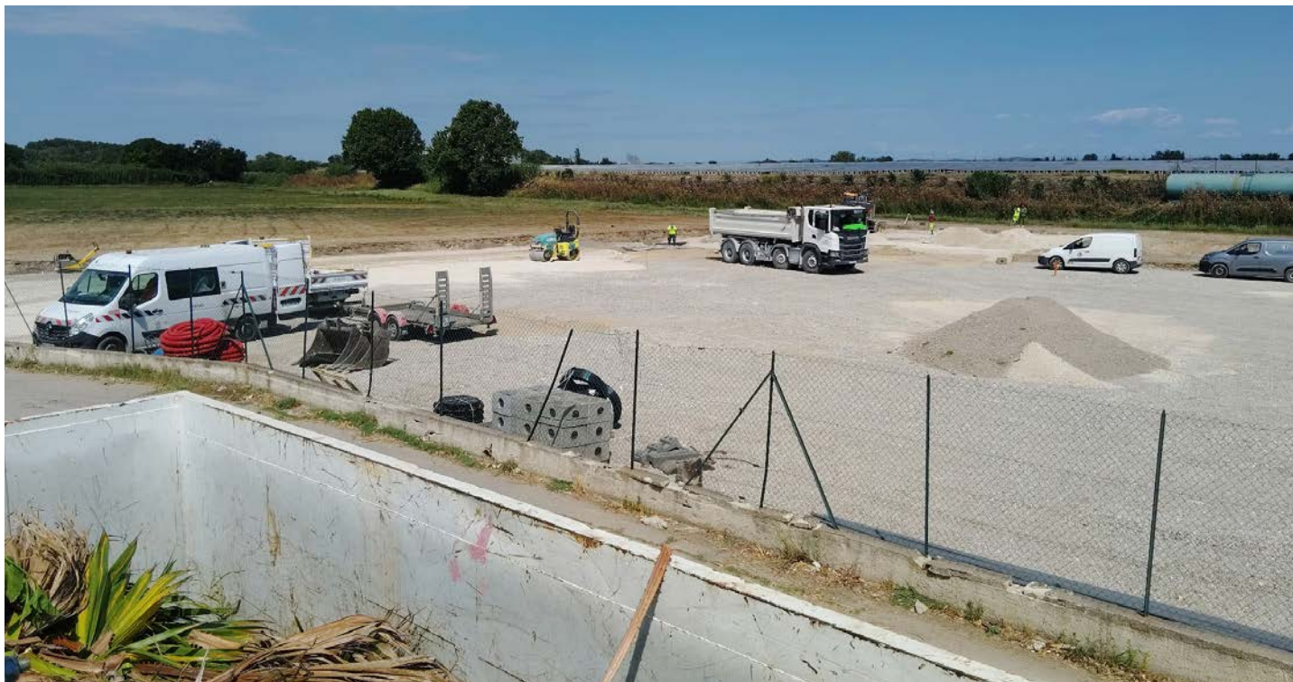
Travaux à la déchèterie de Saint-Rémy-de-Provence
