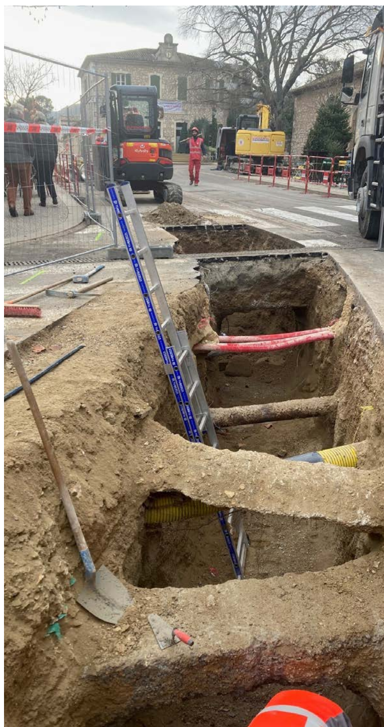
Chantier Molassis à Eygalières
