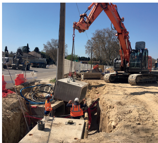
Travaux devant l'esplanade de la mairie à Saint-Etienne du Grès.
