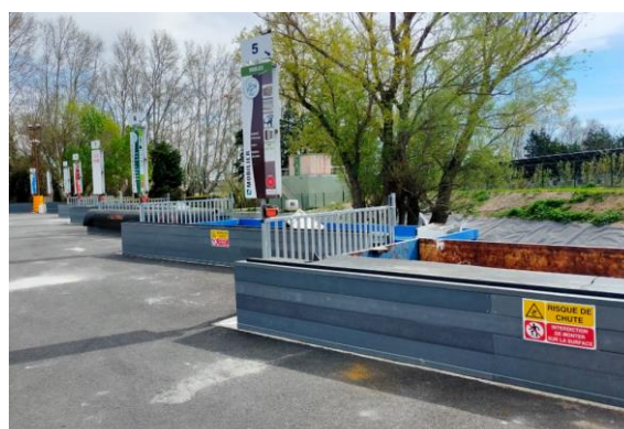
Figure 18 : Exemple de quai de déchargement
